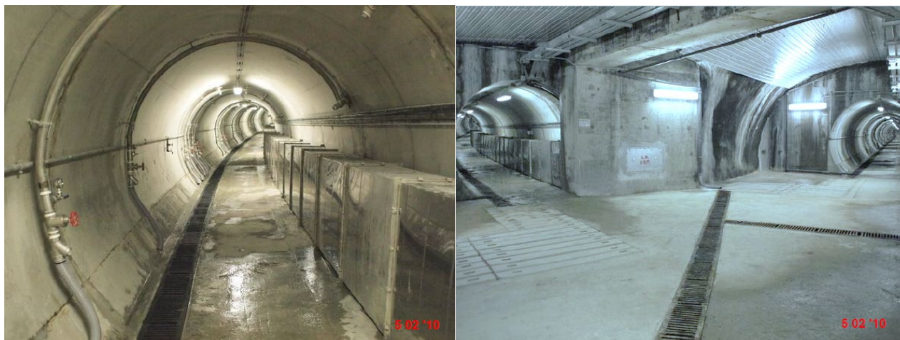
Figura 8 – Vista interna delle gallerie drenanti di Po Shan. A sinistra i drenaggi subverticali installati all'interno del tunnel con rivestimento permanente in calcestruzzo. A Destra il punto di snodo delle 2 gallerie drenanti: a sx la galleria che si snoda nella parte alta del versante mentre, a dx la galleria bassa. Images from "Briefing Notes" by Geotechnical Engineering Office Civil Engineering and Development Department of Hong Kong, October 2011.
