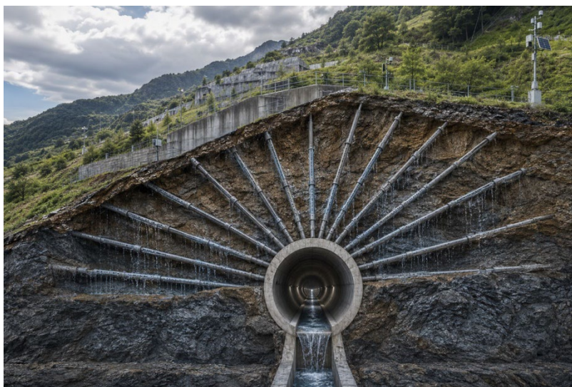
Figura 4 – Rappresentazione di una galleria drenante e di alleggerimento di un versante instabile soggetto ad una DGPV – Ipotesi di intervento – Massimo Chiarelli (2026).
