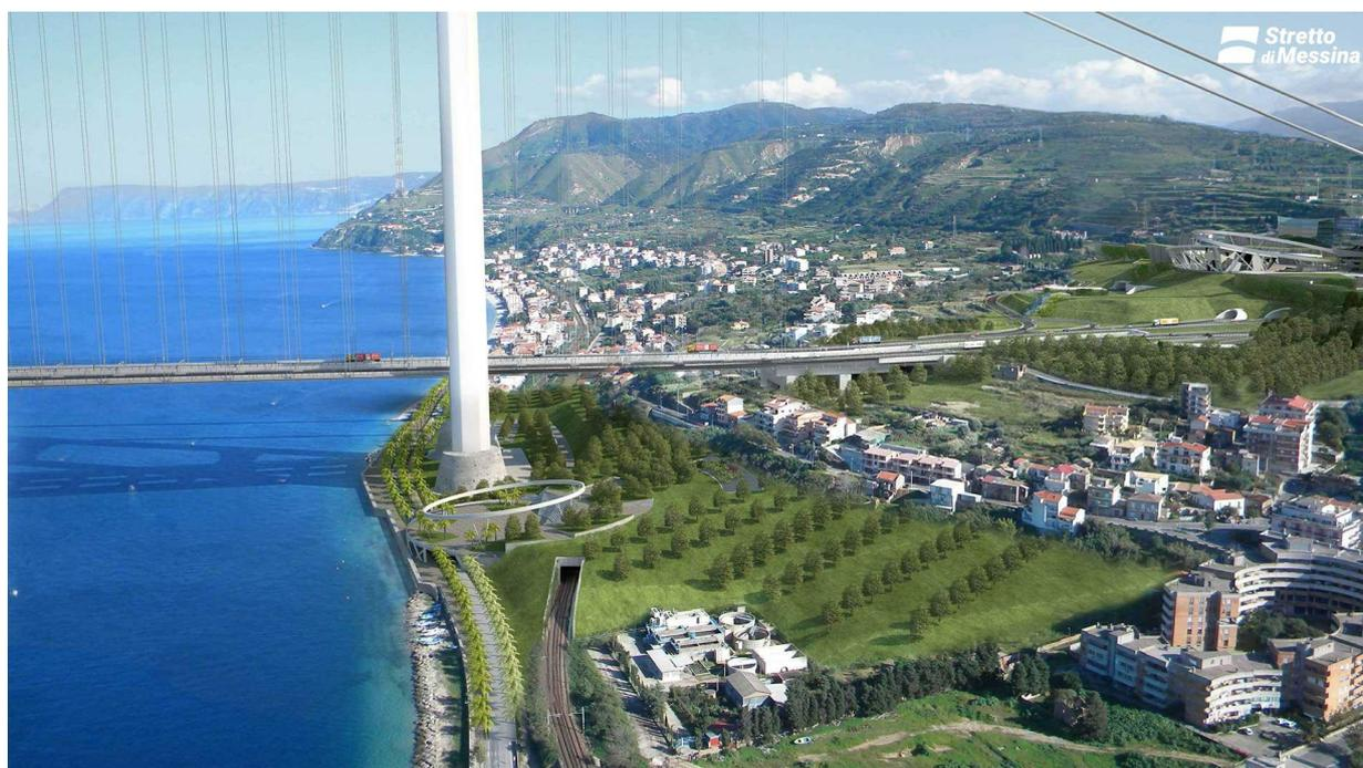
**Figura 1** - Posizionamento pilone del ponte lato Calabria. Lato monte del pilone si vede il tunnel artificiale della variante ferroviaria di Cannitello completato nel 2012. Foto Società Stretto di Messina.
