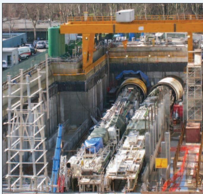
2. L'assemblaggio delle due TBM nella Linea M4 della stazione di Milano Linate
