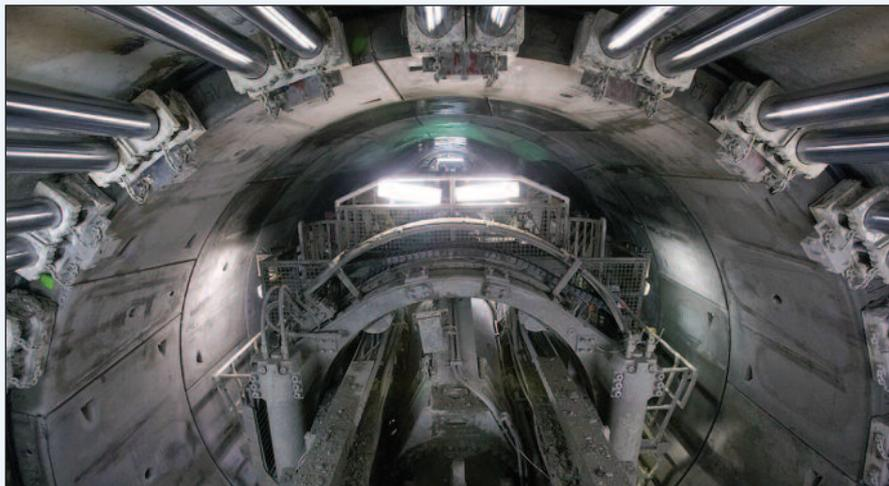
4. I cilindri di spinta in pressione sul rivestimento in conci prefabbricati
