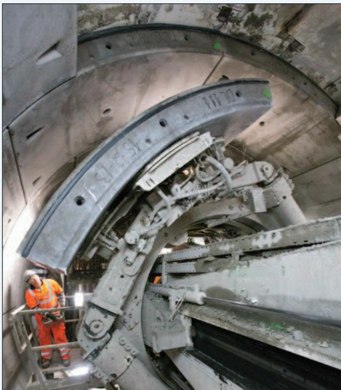
7. L'erettore della TBM durante il posizionamento di un concio
