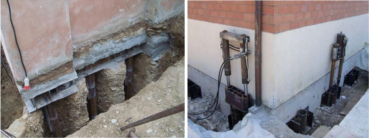
**Figura 8** - Esempio di sostegno/rinforzo delle fondazioni in muratura con una trave in acciaio su micropali. A destra sollevamento e sostegno della trave di fondazione in c.a. di un fabbricato mediante micropali infissi collegati con piastre in acciaio alla trave stessa – Foto ditta Cusi snc di Reggio Emilia.
