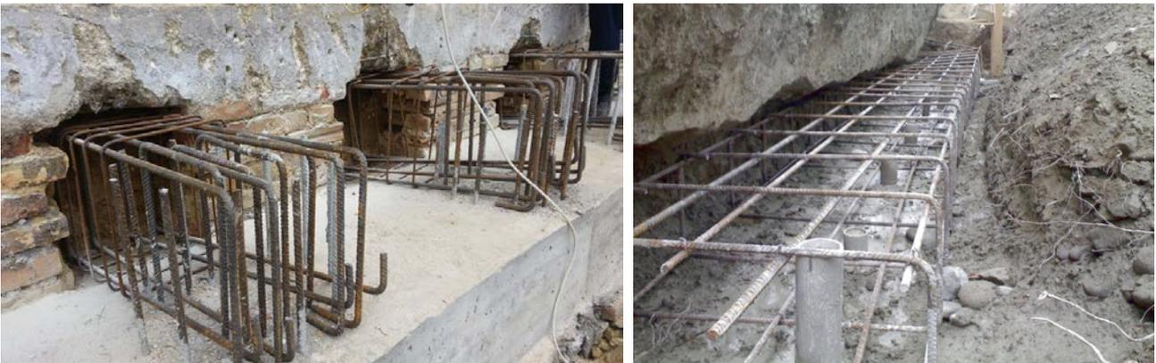
**Figura 9** – Esempio di allargamento della base di fondazione. Nella foto a destra l’allargamento poggia su una fila di micropali in acciaio.
