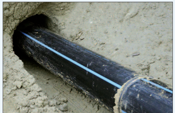
6. Il varo di una tubazione in PE giuntata a caldo
