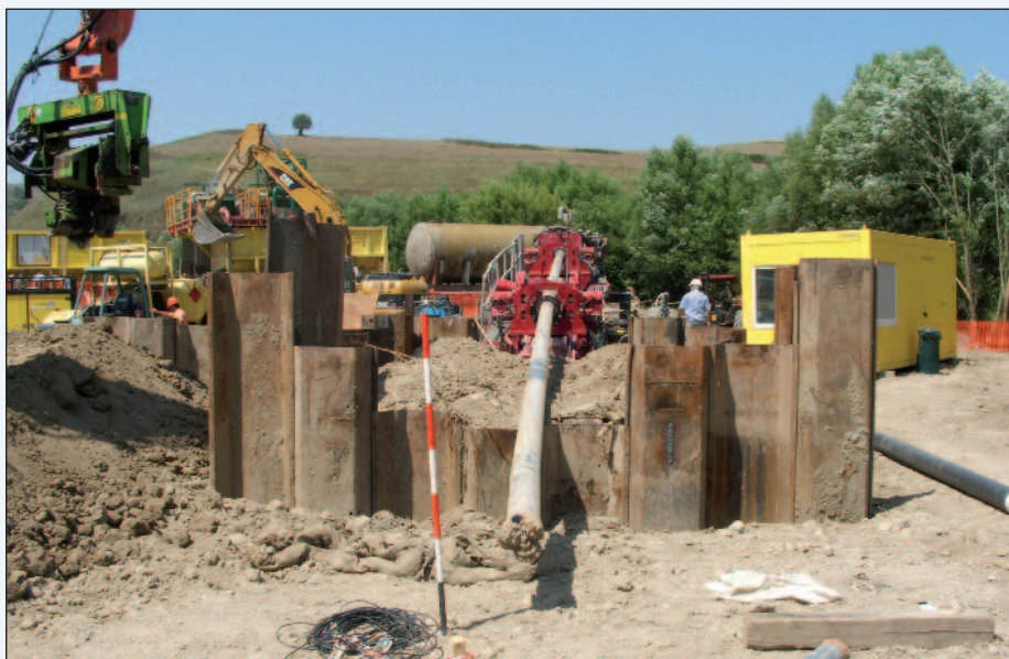
1. Una macchina Rig pronta per l'esecuzione del foro pilota
