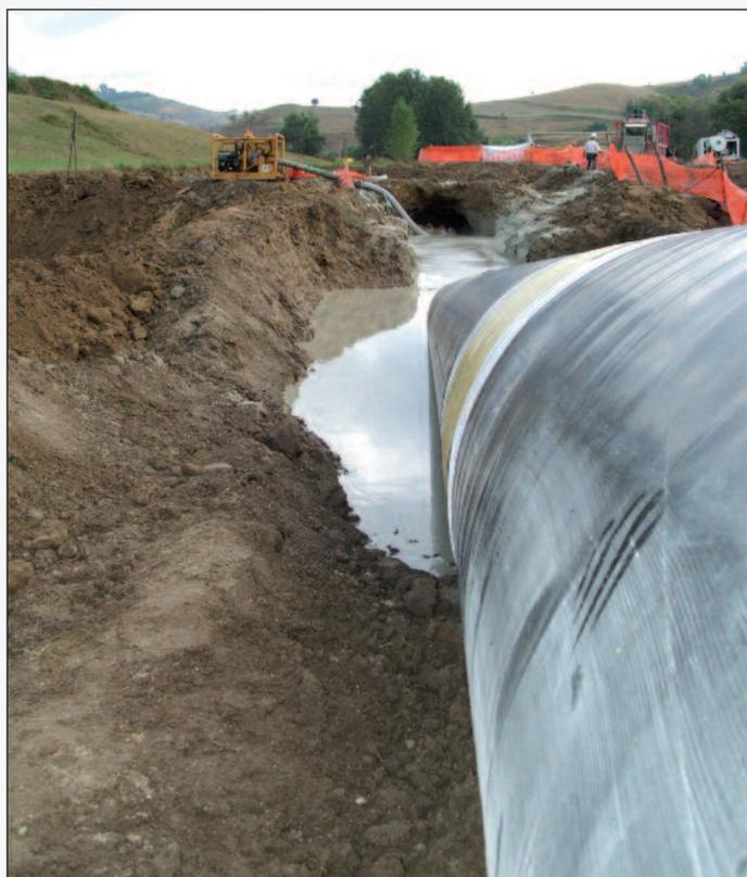
12. La fase di Pull-Back con tubazione immersa in fango bentonitico
