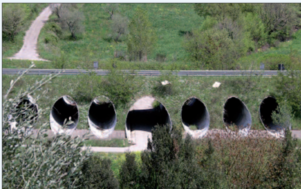
Figura 2 - Una vista generale del rilevato super leggero
