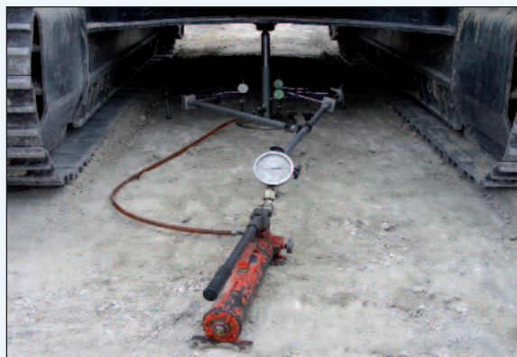
Figura 5 - Alcune prove di carico su piastra eseguite sul rilevato
