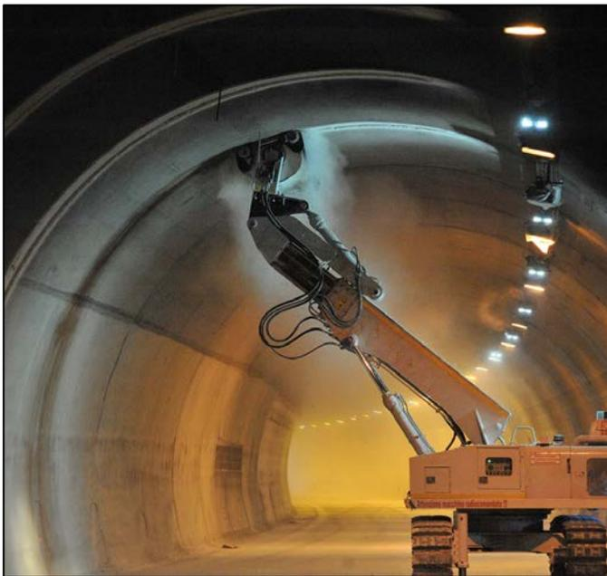
Figura 11 - Intervento di scarifica del rivestimento definitivo per la rimozione delle porzioni di calcestruzzo degradato.
