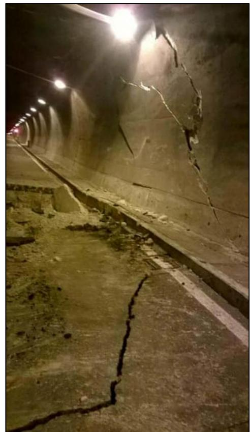
Figura 8 - Galleria di Forca Canapine S.S. 685 delle "Tre Valli Umbre" danneggiata dal sisma del 30 Ottobre 2016.
