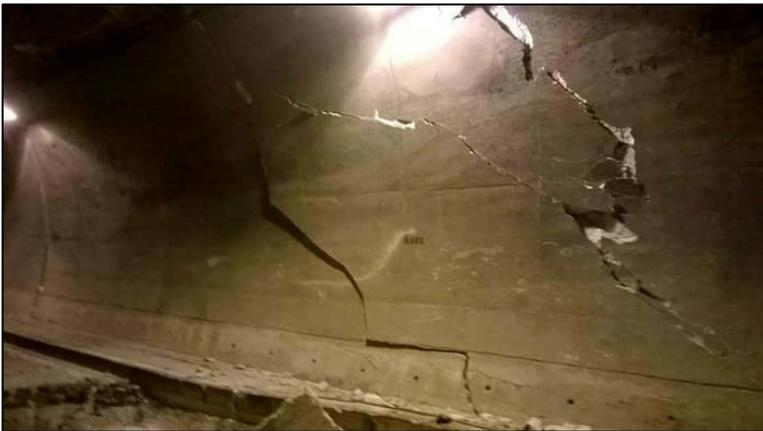
Figura 7 - Galleria di Forca Canapine S.S. 685 delle "Tre Valli Umbre" danneggiata dal sisma del 30 Ottobre 2016.
