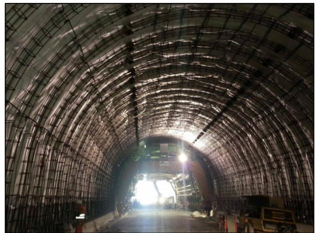
Figura 3 - Autostrada A2 del Mediterraneo – Galleria Fossino, svincolo di Laino Borgo. Intervento strutturale di ricostruzione del rivestimento definitivo in C.A. con spessore ridotto di 30 cm.
