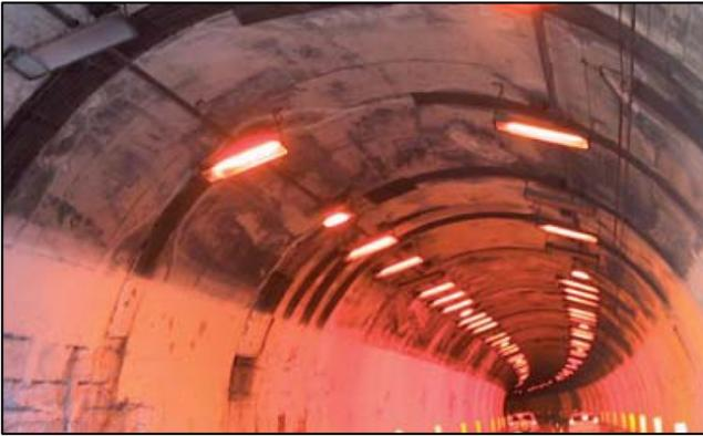
Figura 2 - Autostrada A12 Genova-Livorno, galleria Bordigona. Degrado diffuso del rivestimento definitivo.
