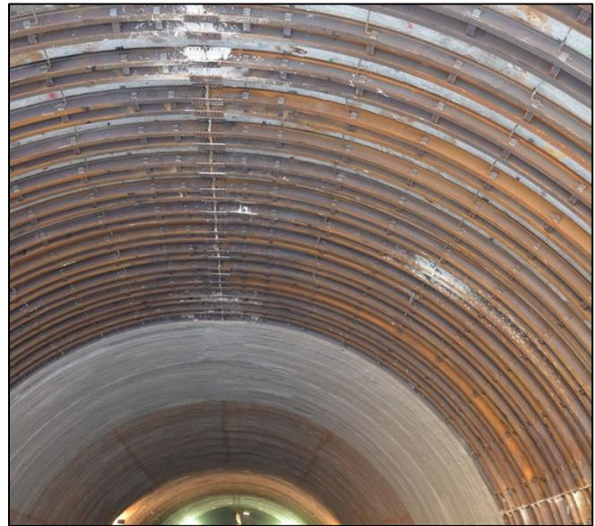
Figura 5 - Intervento strutturale di ricostruzione del rivestimento definitivo in C.A. con posa di nuova centinatura
