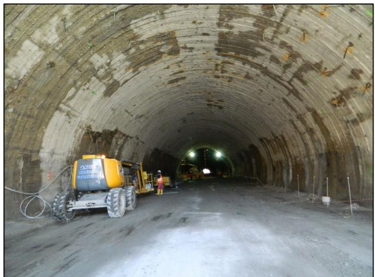
Figura 12 – Galleria del Risorgimento (AN) dopo il completamento dell'intervento di scarifica.
