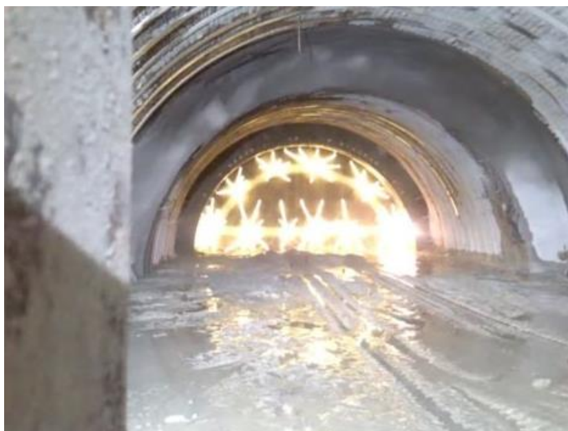
Figura 1 – Abbattimento del fronte in galleria mediante esplosivo
