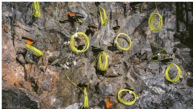
Figura 5 – Caricamento con l'esplosivo delle perforazioni
