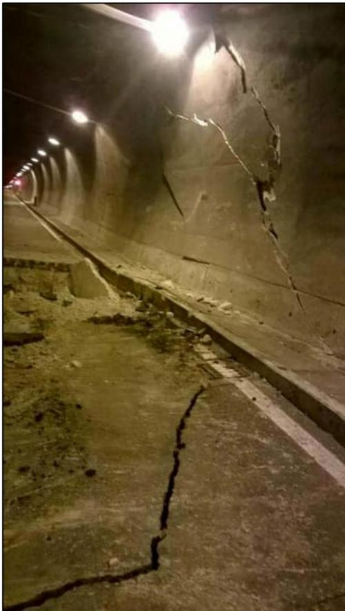
**Figura 1** - Galleria di Forca Canapine S.S. 685 delle "Tre Valli Umbre" danneggiata dal sisma del 30 Ottobre 2016.
