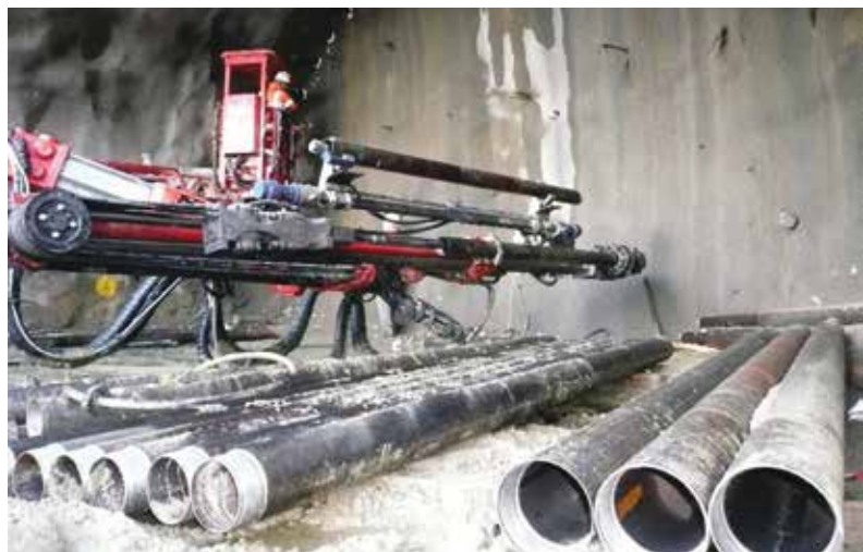
2. La fase operativa di esecuzione dell'Umbrella Arch mediante tubi in acciaio
