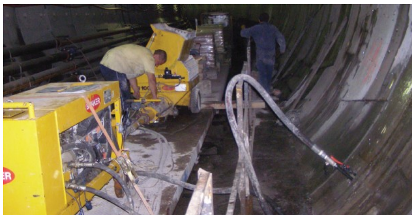
Figura 7 – Iniezione di resina poliuretantica a tergo del rivestimento definitivo
