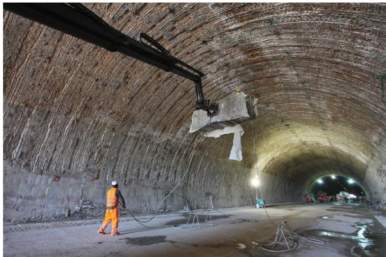
Figura 4 – Fresatura totale della calotta con rimozione del calcestruzzo superficiale ammalorato
