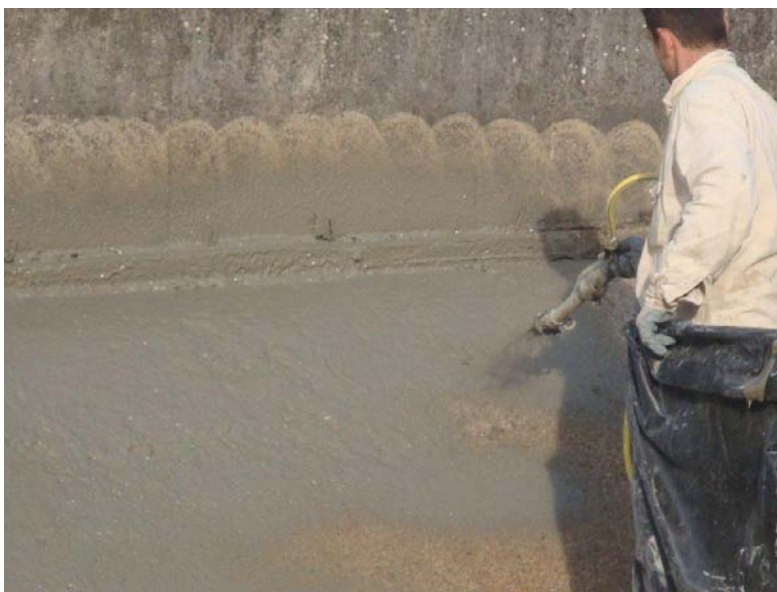
Figura 5 – Applicazione a spruzzo del primo strato di cemento osmotico
